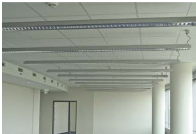
Bestandsleuchte mit T5 oder T8. Pendelleuchte
